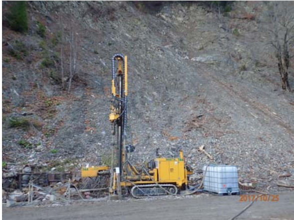
Foto 1. Echipamentul de foraj geotehnic folosit
