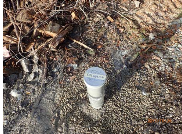
Foto 2. Foraj de monitorizare piezometrică
