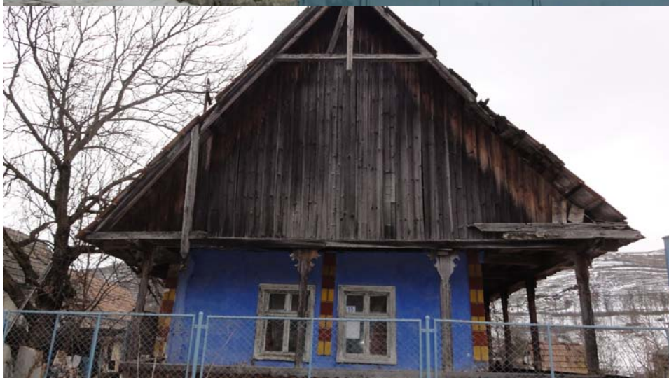
Figură 42– Casă cu valoare arhitecturală din Făureni nr. 55
