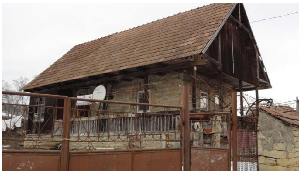
Figură 44– Casă cu valoare locală având intervenții inadecvate (geam termopan cu pvc)
