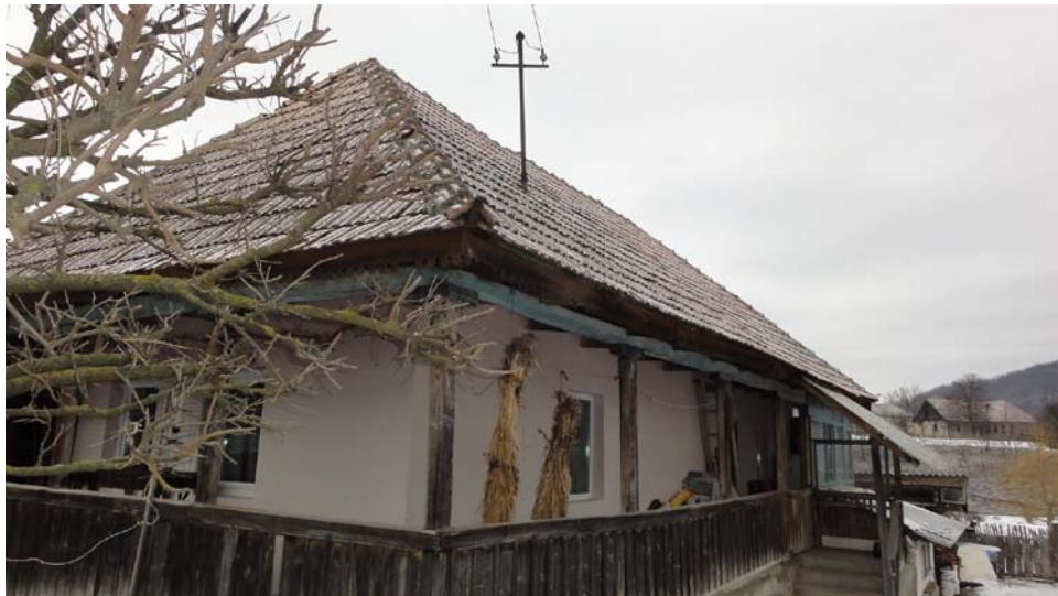
Figură 57– Casă cu valoare arhitecturală din Băbuțiu nr.29
