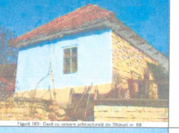
Clădire nr. 69 - clădire de locuit cu foisor. Volumetria este tradițională, monovolum. Se observă decorațiunile ancadramentelor realizate în tencuială, cât și faptul că înspire vecinii zidăria de piatră a rămasă netencuită.
