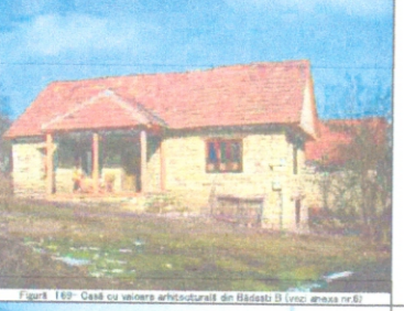
Clădire B - clădire cu foisor cu stâlpi de lemn, volumetrie adecvată pantei terenului, cu acces în pivniță de la nivelul solului. Se remarcă paramentul de zidărie de piatră netencuită și volumetria monovolum tradițională.
