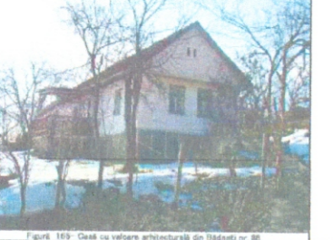
Clădire nr. 88 - clădire de locuit monovolum cu volumetrie tradițională, acoperiș în două ape. Golurile sunt nealterate la fel ca și ancadramentele ferestrelor, se observă brăul decorativ și simetria fațadei dinspre stradă. Din păcate, foisorul a fost ușor alterat, însă proporțiile și tâmplăria ferestrelor se mențin.
