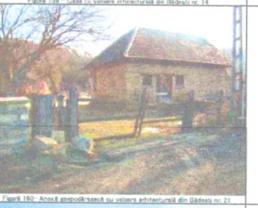
Clădire nr. 21 - clădire anexă cu volumetrie tradițională realizată din zidărie de piatră netencuită. Se remarcă golurile nealterate și acoperișul în patru ape din țigla ceramică.
