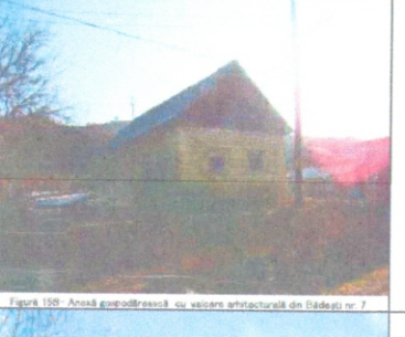
Clădire nr. 7 - clădire anexă cu volumetrie tradițională realizată din zidărie de piatră netencuită. Se remarcă golurile nealterate.
