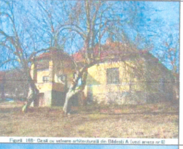
Clădire A - clădire cu foisor cu stâlpi de zidărie, volumetrie adecvată pantei terenului, cu acces în pivniță de la nivelul solului. Se observă braiele decorative și ancadramentele de la gurile ferestrelor.
